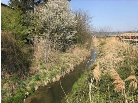
Der Göllersbach im Bereich des Bahnhofs: ein begradigter Abfluss. (Foto: GöFF, HK)
